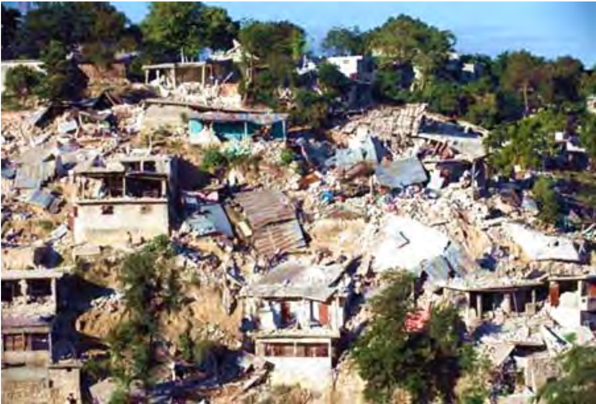
Последствия землетрясения на Гаити 12 января 2010 г. Фото ©AFP из архива Vesti.kz ( http://vesti.kz/crash/37197/ )
